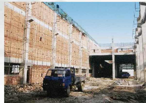
厂房立柱结构建设
