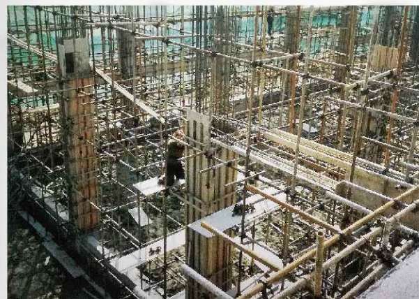
厂房结构搭建
